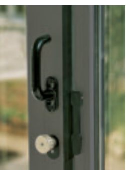
Ein Element mit Drehverschluss, ein Element als Gehtüre ausgebildet mit Drücker und Kabal-Drehknopf-Zylinder
