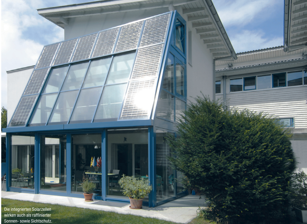
Rund 30 Prozent des Stroms für den Verbrauch des Einfamilienhauses in Langenthal erzeugt der Wintergarten.
